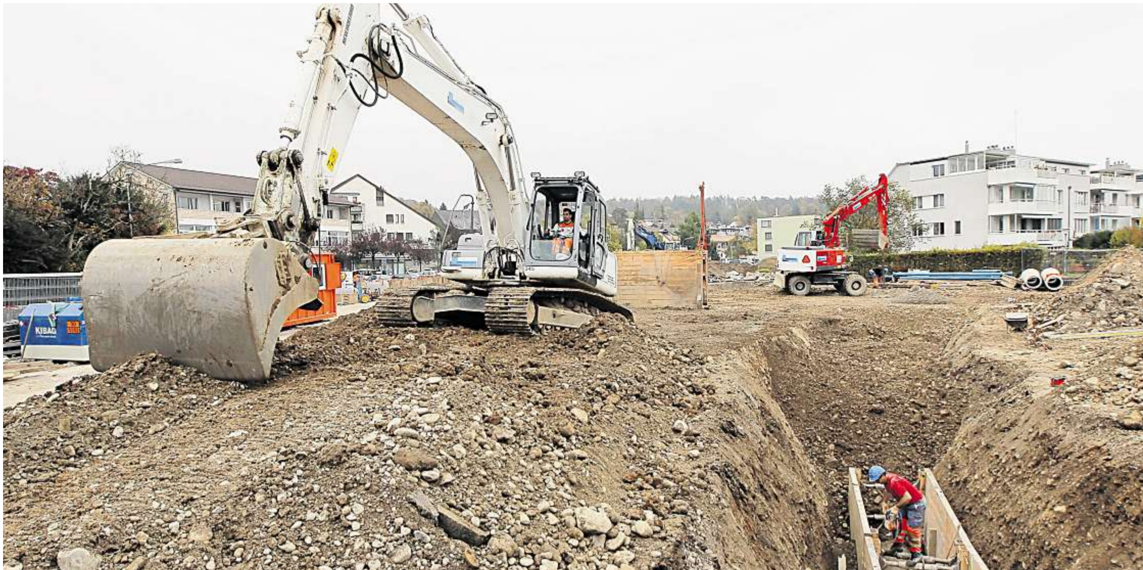
Beim Kreisel ist bald fertig gebaut, dafür geht es hier weiter: Zwischen Migros und Post (hinten) wird in den kommenden Monaten ein riesiges Loch für eine öffentliche Tiefgarage ausgehoben. Bild: Balz Murer
